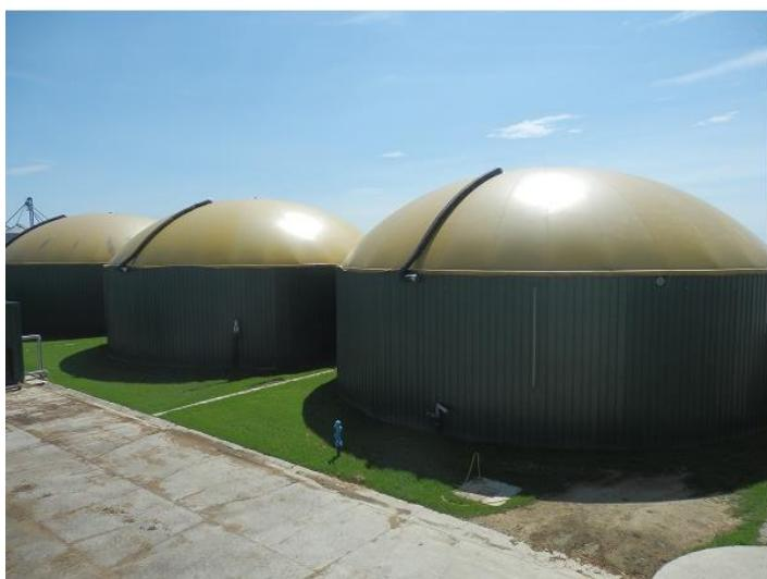
**Slika 2.11. Digestor s balonom na vrhu u bioplinskom postrojenju [3]**
