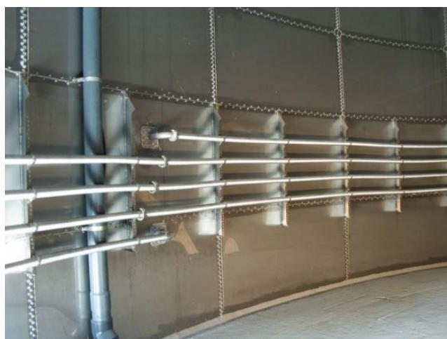
Slika 2.10. Cijevi za grijanje unutar fermentora [4]
