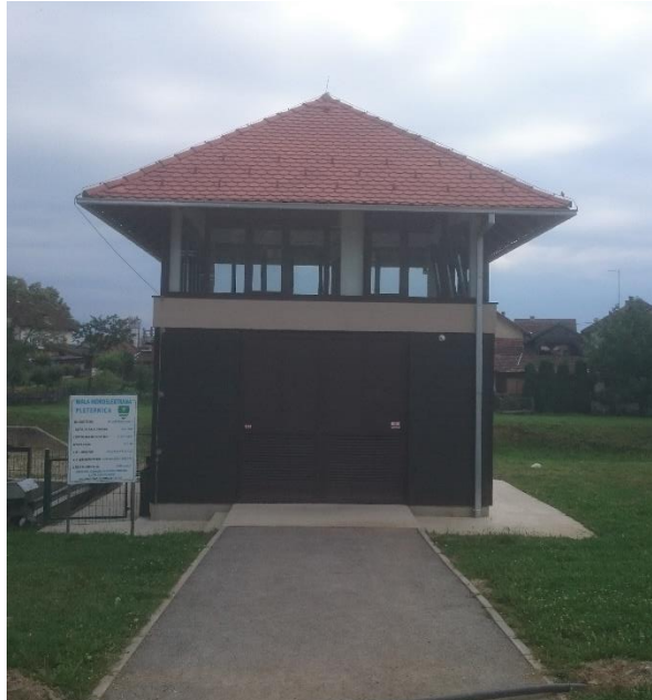
Slika 2.5. Mala hidroelektrana „Pleternica“ [20]
