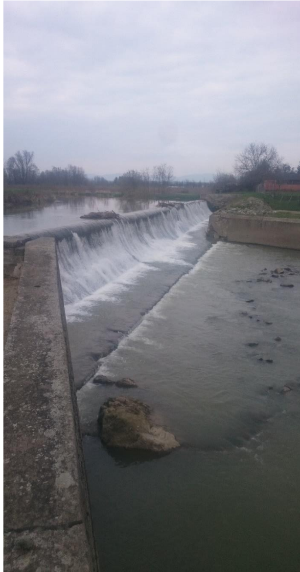
Slika 2.3. Brana na rijeci Orljavi u Pleternici [20]
