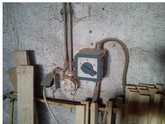
Slika 3.7. Preklopka zvijezda-trokut u pogonu
