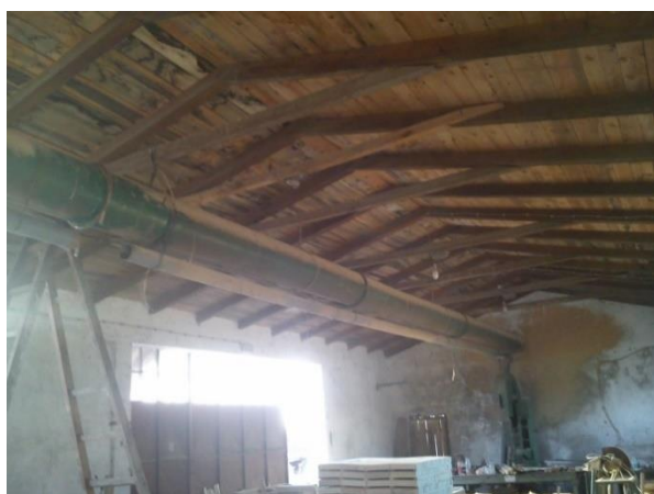
Slika 6.3. Cjev usisnog kanala za piljevinu
