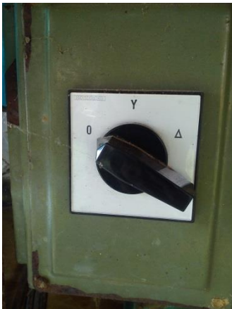
Slika 3.7. Preklopka zvijezda-trokut u pogonu
