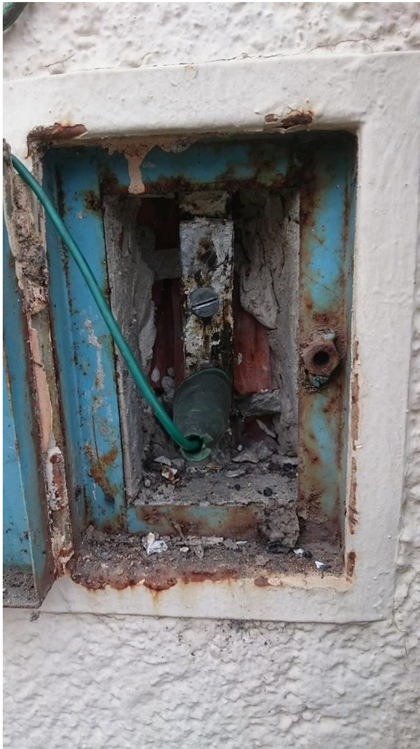
Slika 4.1. Način spajanja na uzemljivač na srednjoj zgradi Mašinskog fakulteta
