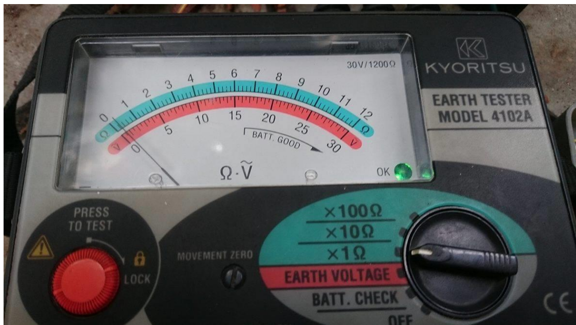
Slika 4.8. Otpor uzemljivača na zgradi FTN-a
