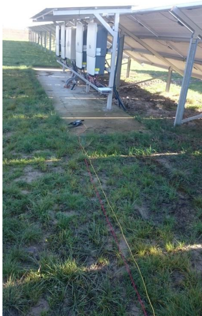
Slika 4.9. Grupa invertora 1 s mjernim uređajem i vodičima
