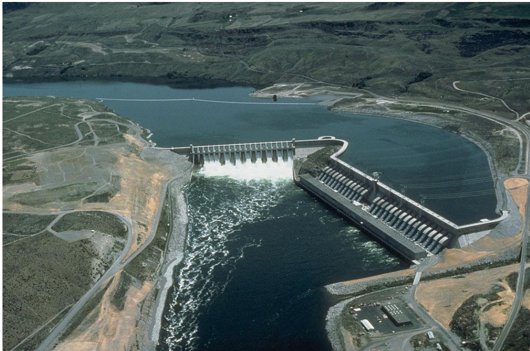
Slika 2.2. Protočna hidroelektrana [29]
