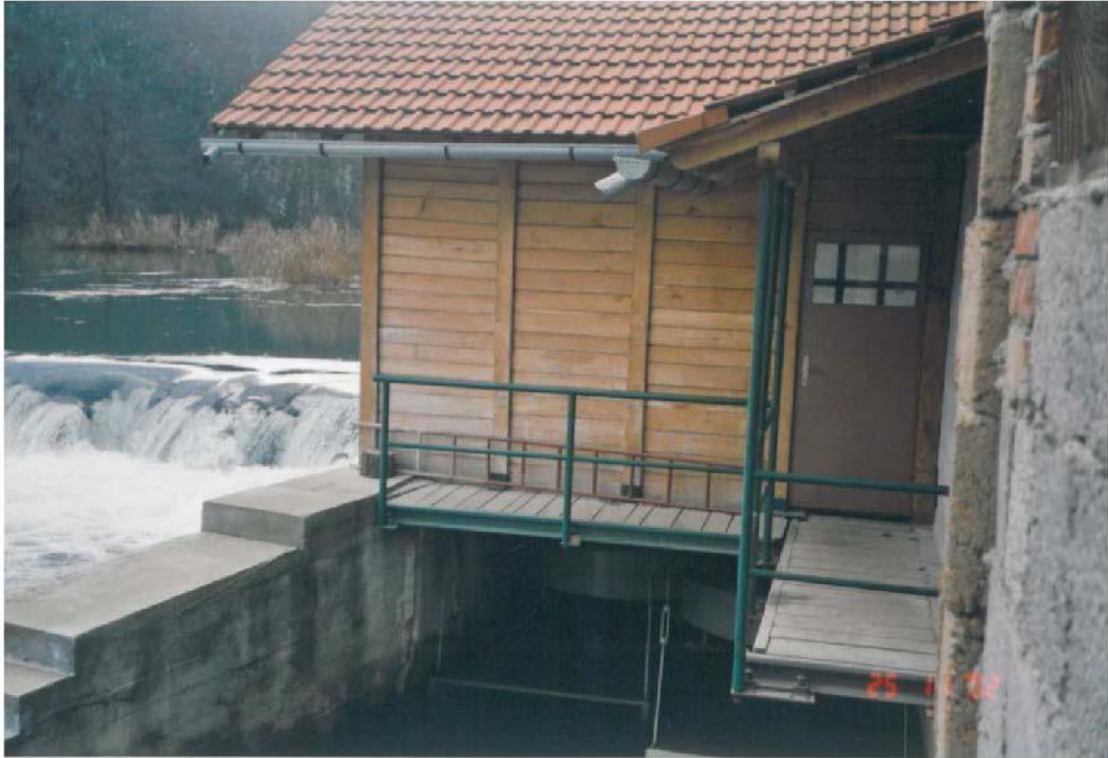
Slika 2.8. Mikro hidroelektrana Mataković, Mrežnica, instalirana snaga 15 kW [6]
