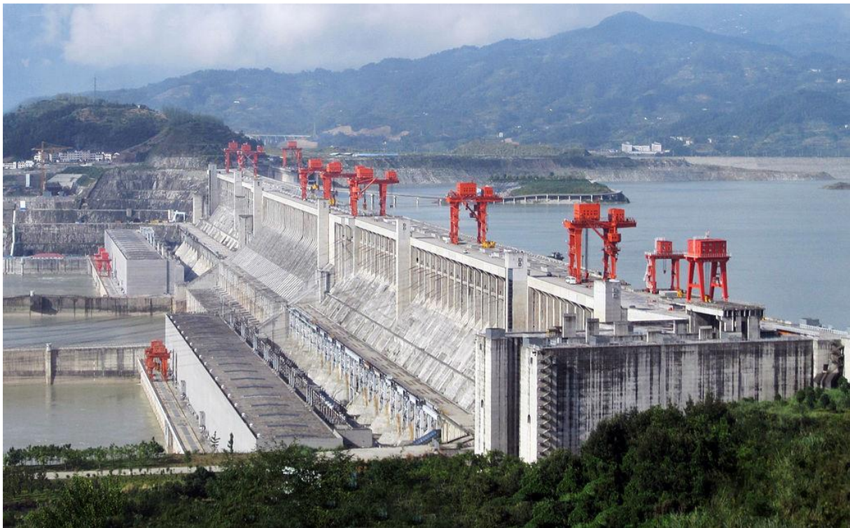
Slika 2.7. Hidroelektrana Tri klanca, Kina, instalirana snaga 22,5 GW, [5]
