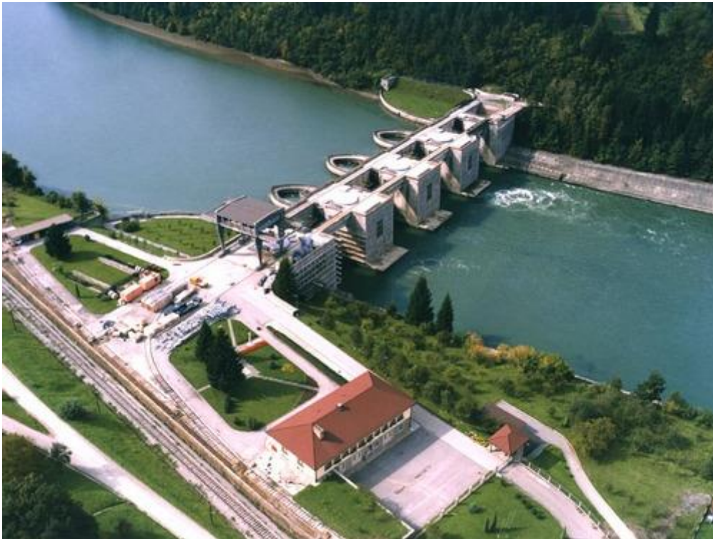
Slika 2.5. Hidroelektrana Vuzenica (agregati su u stupovima brane) [3]
