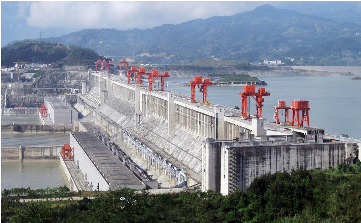
Slika 2.7. Hidroelektrana Tri klanca, Kina, instalirana snaga 22,5 GW, [5]
