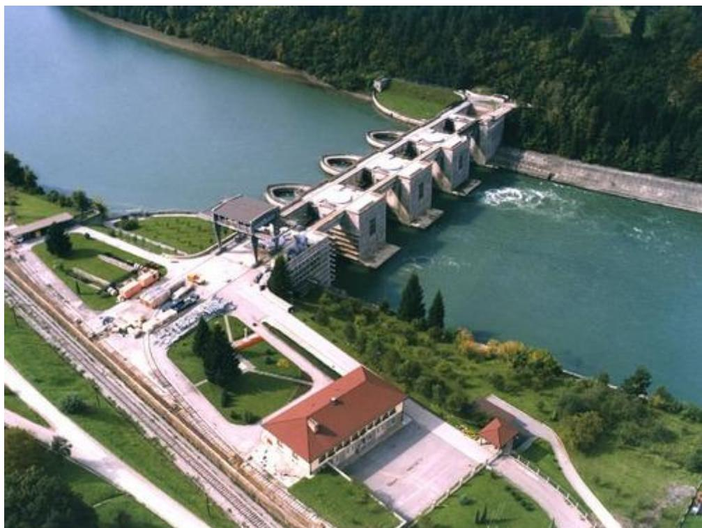
**Slika 2.5. Hidroelektrana Vuzenica (agregati su u stupovima brane) [3]**
