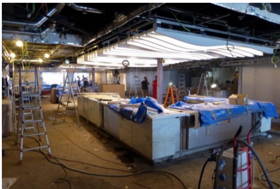
Slika 5.5.5 Promjena interijera jedne od kuhinja na brodu i naša oprema za napajanje
