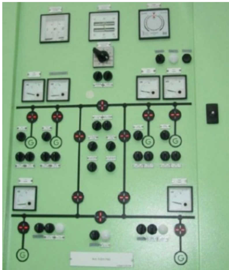
Slika 4.3.5.2. Panel za sinkronizaciju na brodu
