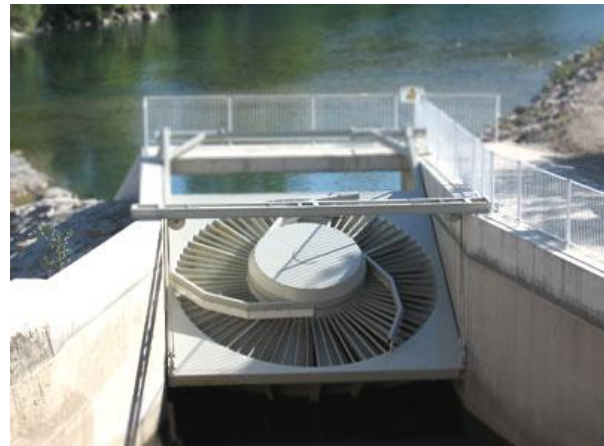
Slika 2.13. VLH turbina u povučenom položaju
