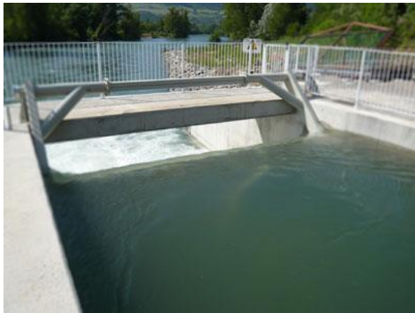
Slika 2.12. VLH turbina u radnom položaju
