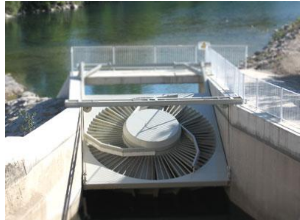
Slika 2.13. VLH turbina u povučenom položaju
