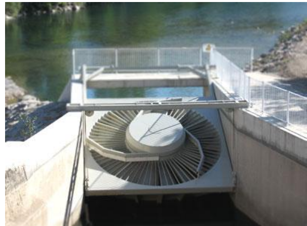
Slika 2.13. VLH turbina u povučenom položaju
