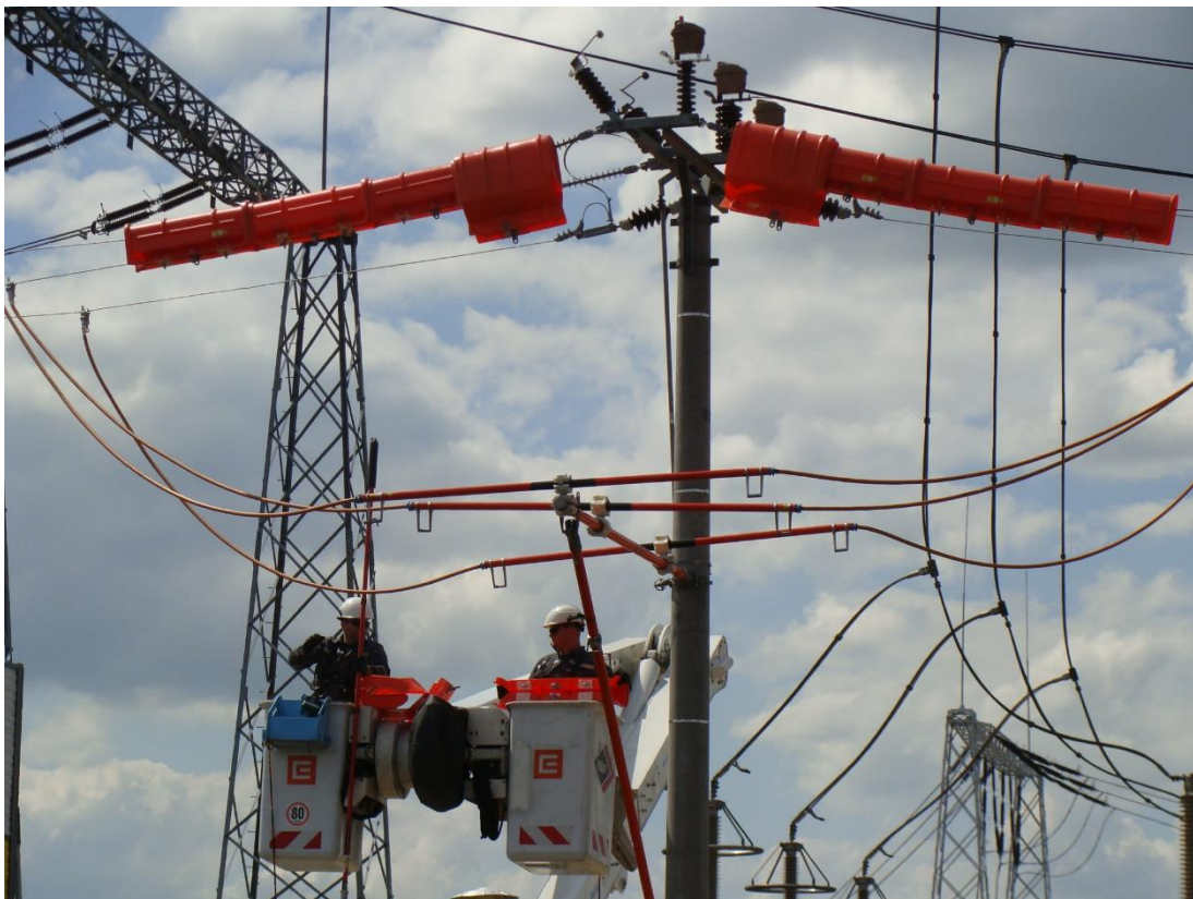
Sl. 4.5. Korištenje privremenih prenosnica tijekom RPN-a [7]
