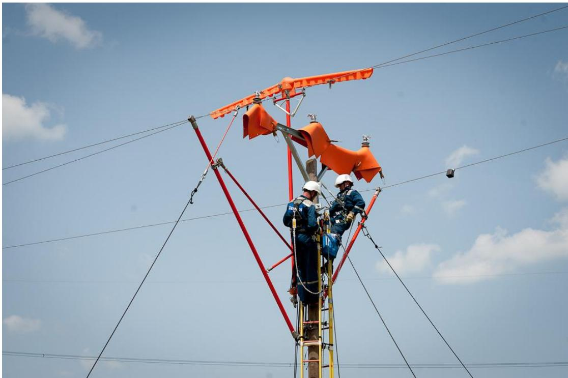
**Sl. 4.1. Eliminiranje potencijala tijekom rada na konzoli stupa [12]**
