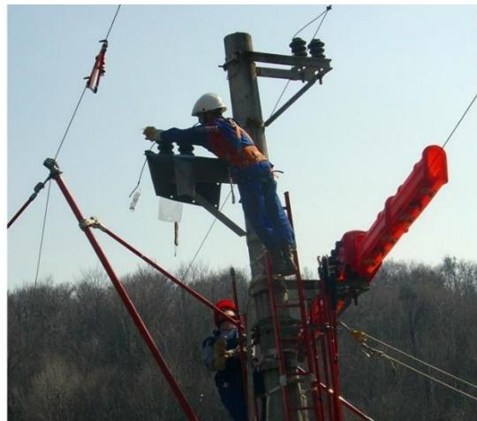
**Sl. 3.12. Postupak zamjene izolatora metodom rada „u dodiru“ korištenjem: autoplatorme (lijevo) i izolacijskih ljestava (desno) [7]**
