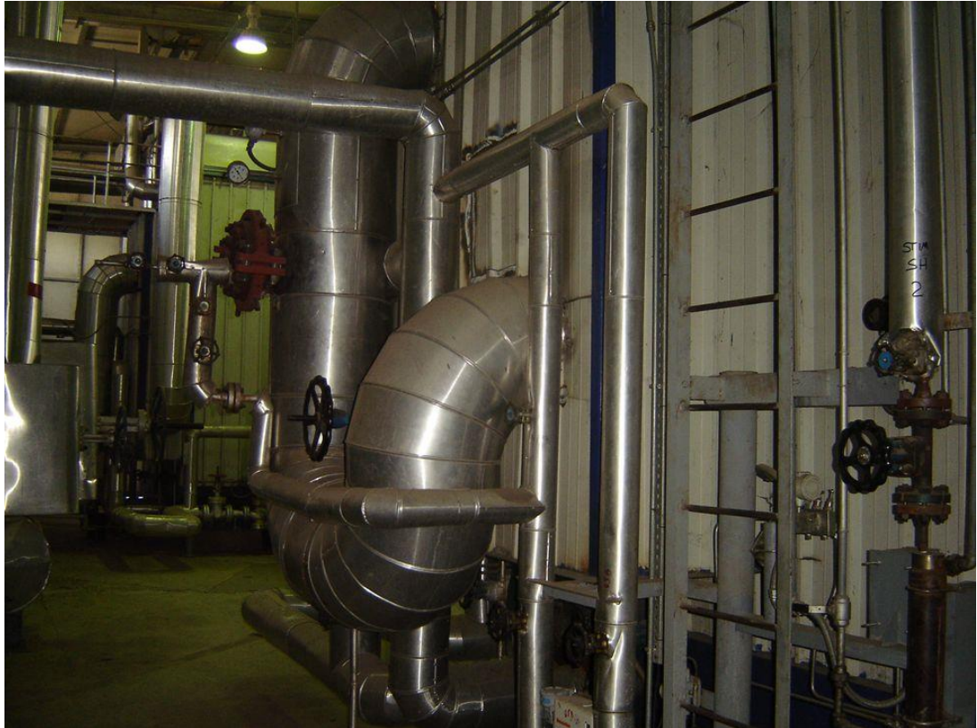
Sl. 3.3. Integral kotao „DĐ“ Slavonski Brod[10].
