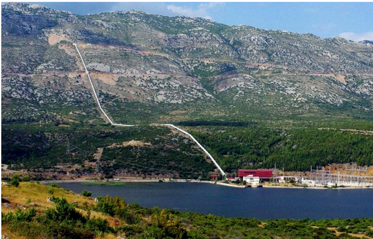
Slika 2.3. Reverzibilna hidroelektrana, [5]
