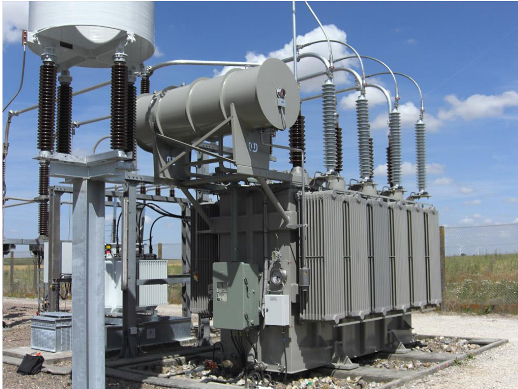
Slika 4.7. Energetski uljni transformator, [27]
