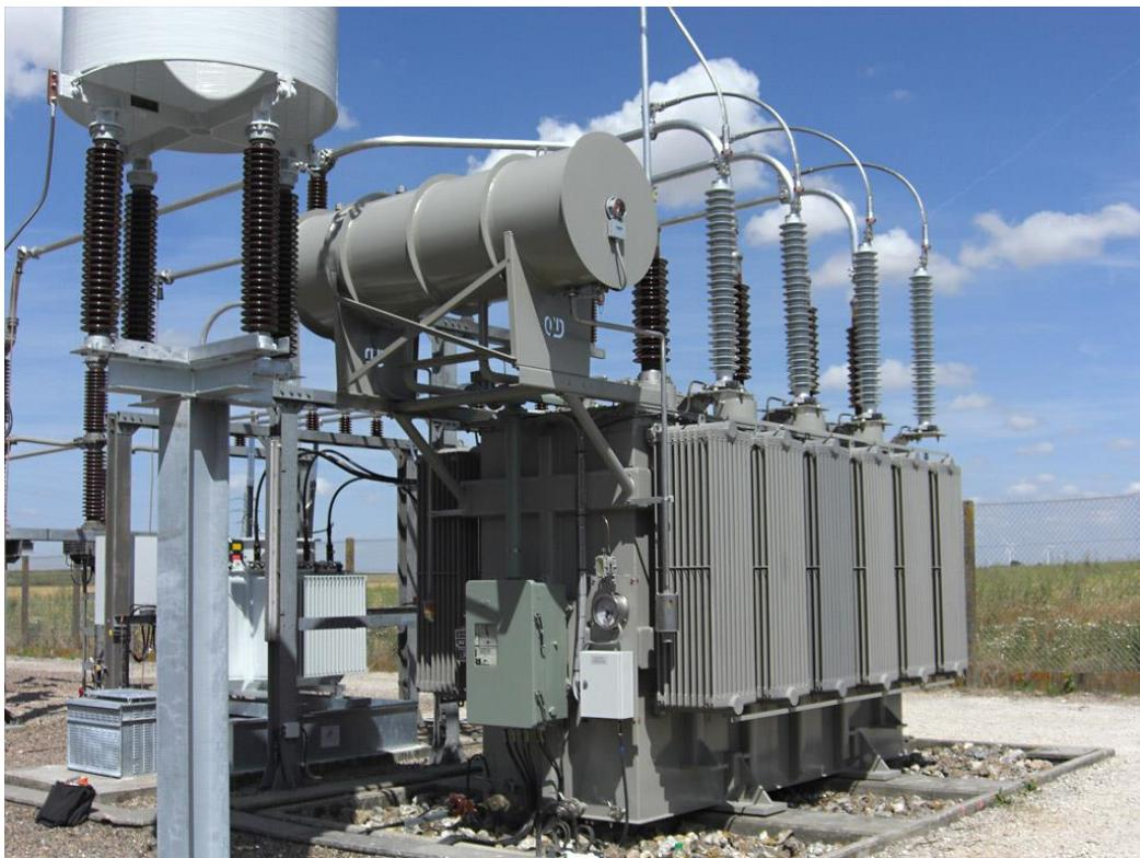
**Slika 4.7. Energetski uljni transformator, [27]**
