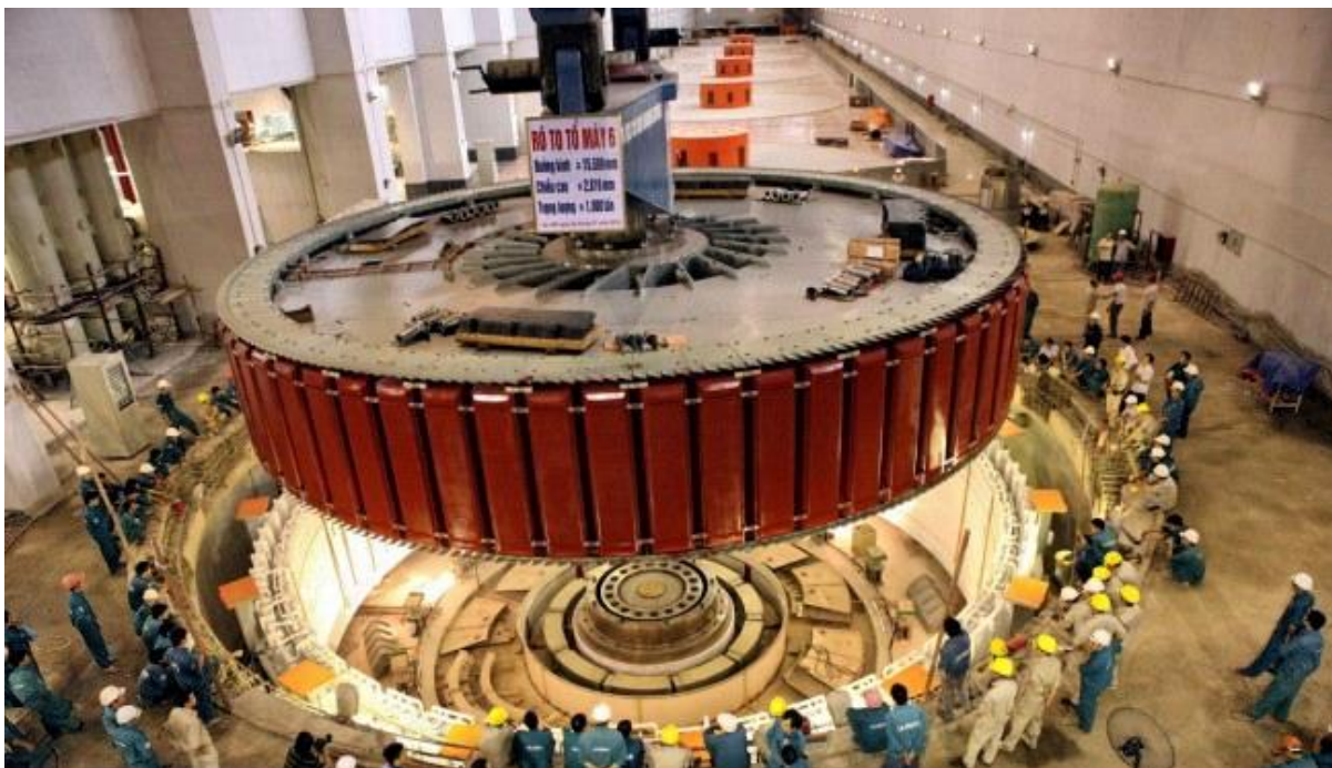
Slika 4.5. Sastavljanje rotora u hidroelektrani, [26]
