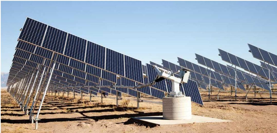
**Slika 3.3.** Primjer solarne farme s polarnim sustavom praćenja u Greater Sandhill, Mosca, SAD [10]
