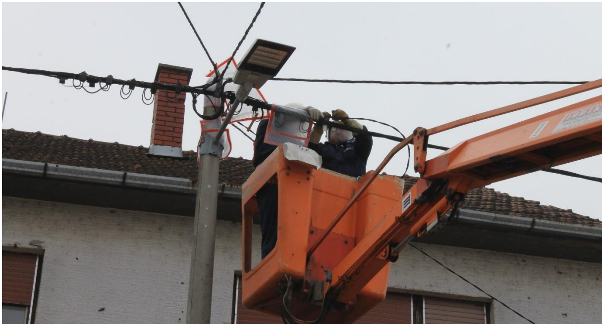
Slika 5.2. Spajanje novog kućnog priključnog ormarića na SKS
