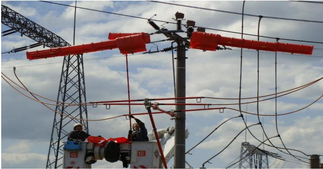
Slika 3.2. Metoda rada na udaljenosti u autoplatforni
