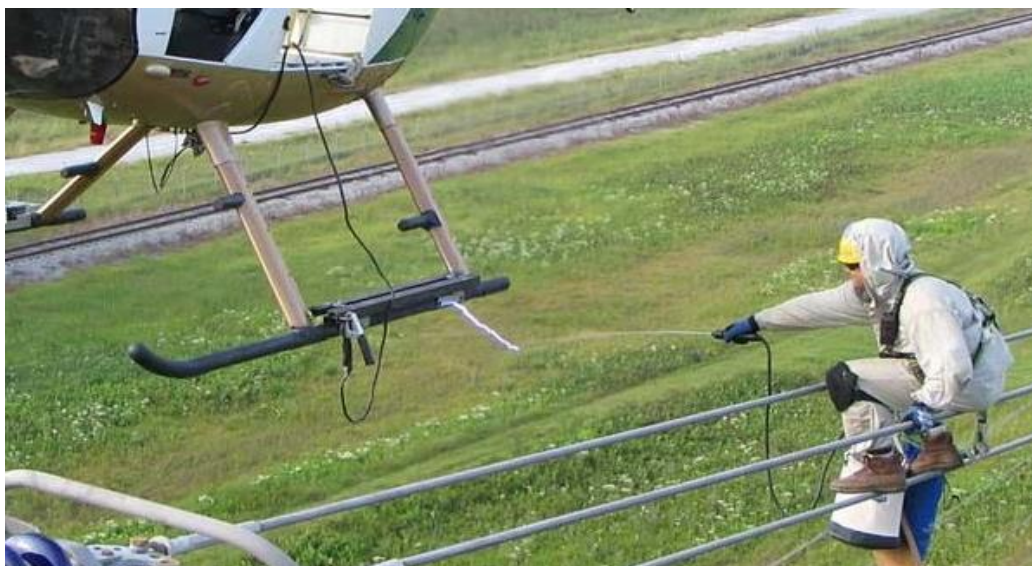
Slika 3.9. Tehnologija RPN metodom „na potencijalu“ [6]
