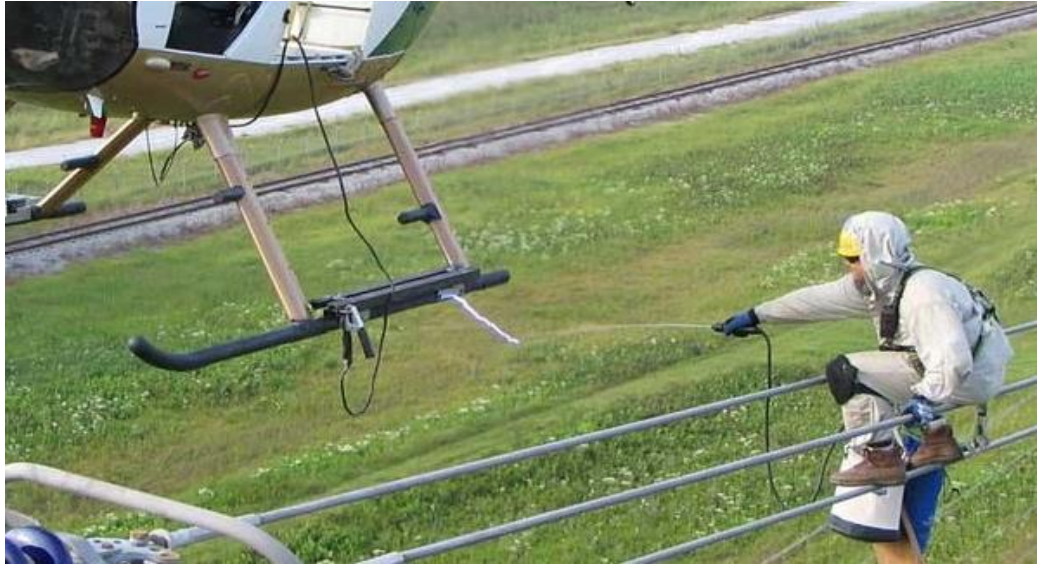
Slika 3.9. Tehnologija RPN metodom „na potencijalu“ [6]
