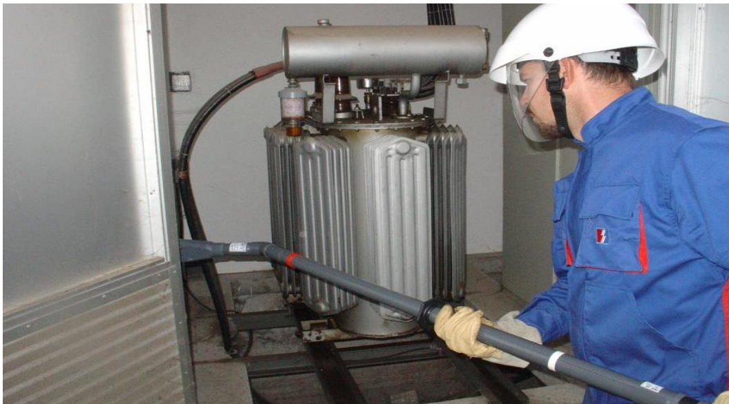
Slika 3.4. Čišćenje transformatorske prostorije u RPN [1]
