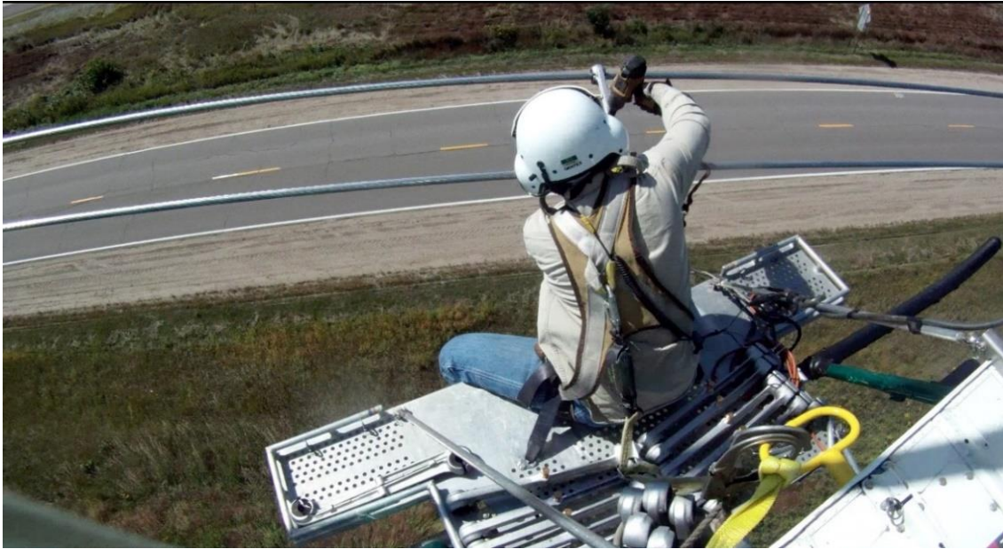
Slika 3.10. Tehnologija RPN metodom „na potencijalu“ uz pomoć helikoptera [7]
