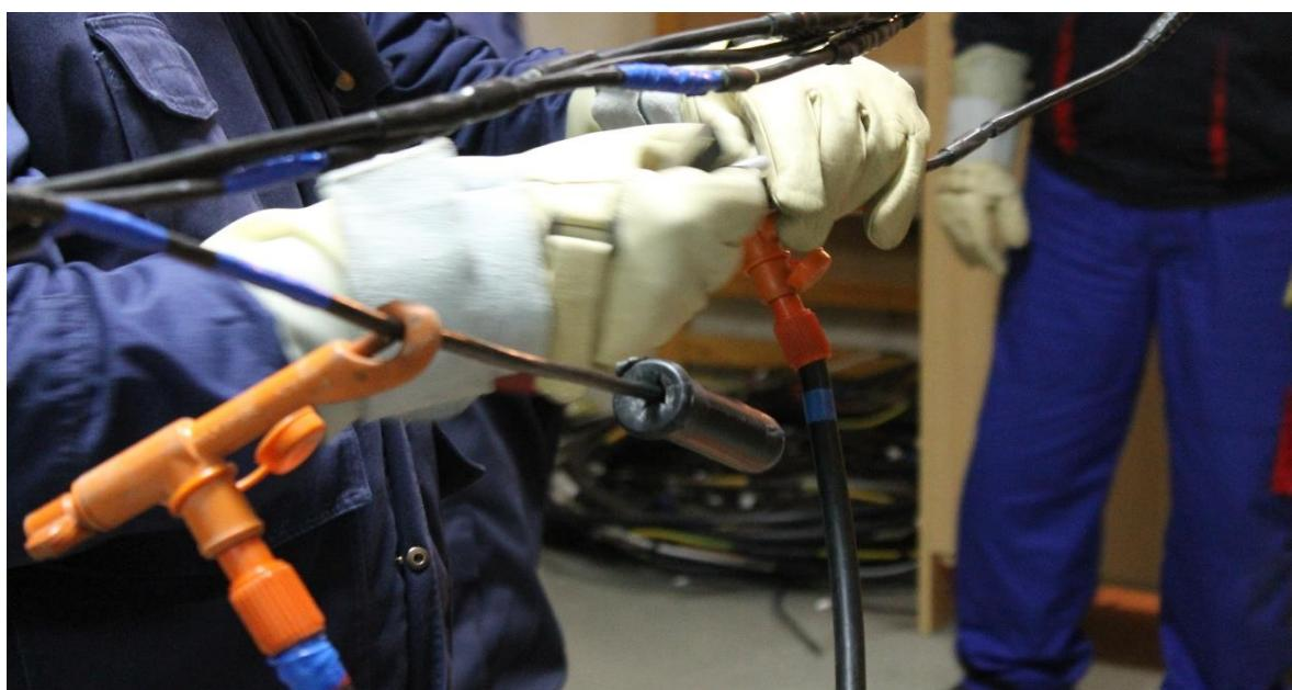
**Slika 5.4.** Postavljanje premosnice na oštećeni vodič u RPN
