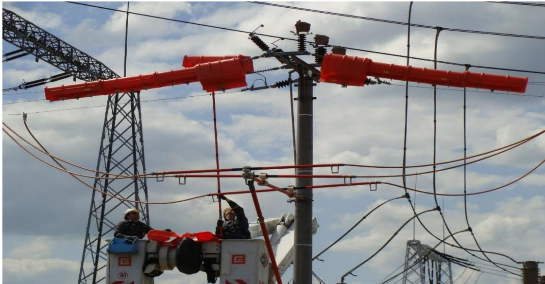
**Slika 3.2.** Metoda rada na udaljenosti u autoplatformi
