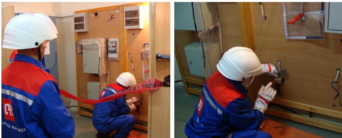
**Slika 5.1.** Izmjena radne stezaljke u sklopu obuke u učionici HEP - NOC
