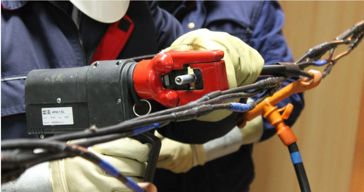
Slika 5.5. Postupak prešanja metalne čahure u koju ulaze oba kraja vodiča
