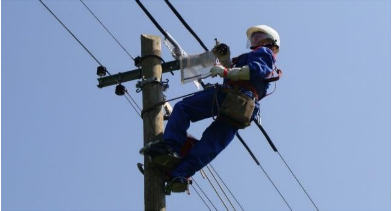
Slika 5.6. Operater na drvenom stupu vrši izmjenu izolatora u RPN [5]
