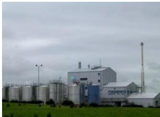
Slika 2.20. Elektrana na biomasu u Hrvatskoj - Strizivojna Hrast 3.3 MW [11]
