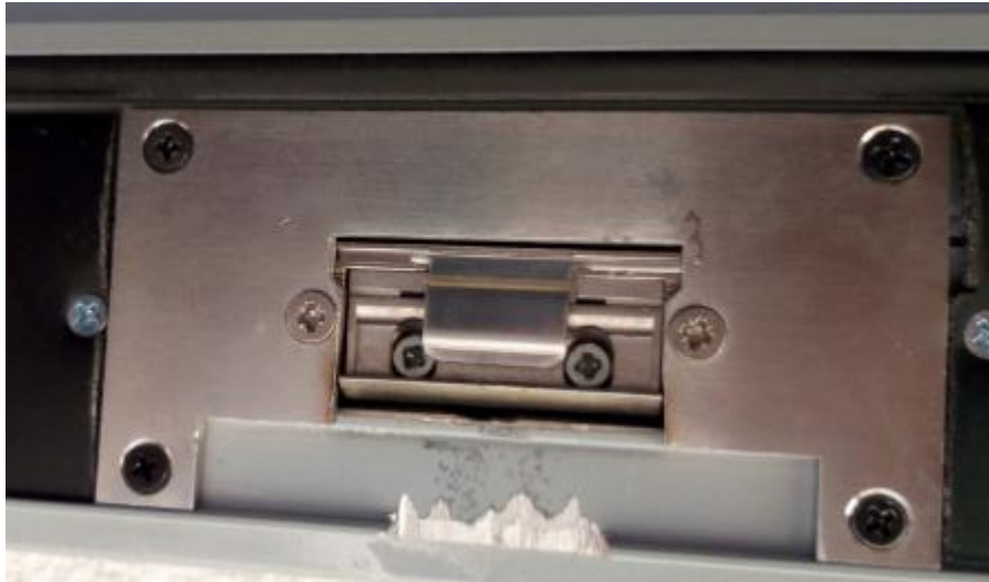
Sl. 5.2. Evakuacijski elektro prihvatač sa kontaktom vrata.
