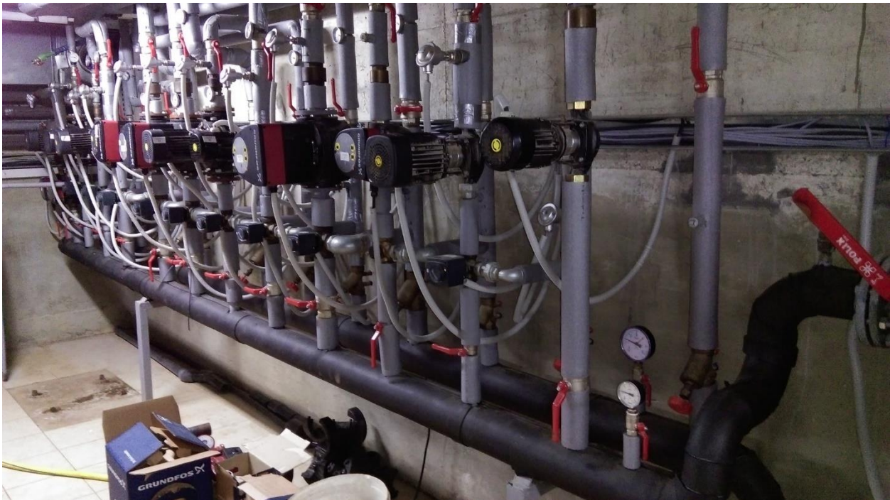
Slika 2.1. Krugovi grijanja u kotlovnici
