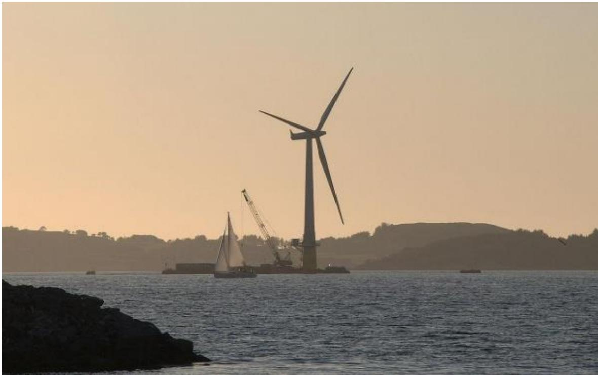
**Slika 2.6. Plutajući vjetroagregat Hywind (slika preuzeta iz [6])**
