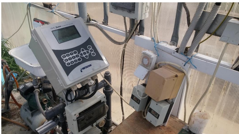
Slika 3.2. Upravljačka jedinica sustava NETAFIM NMC-Junior
