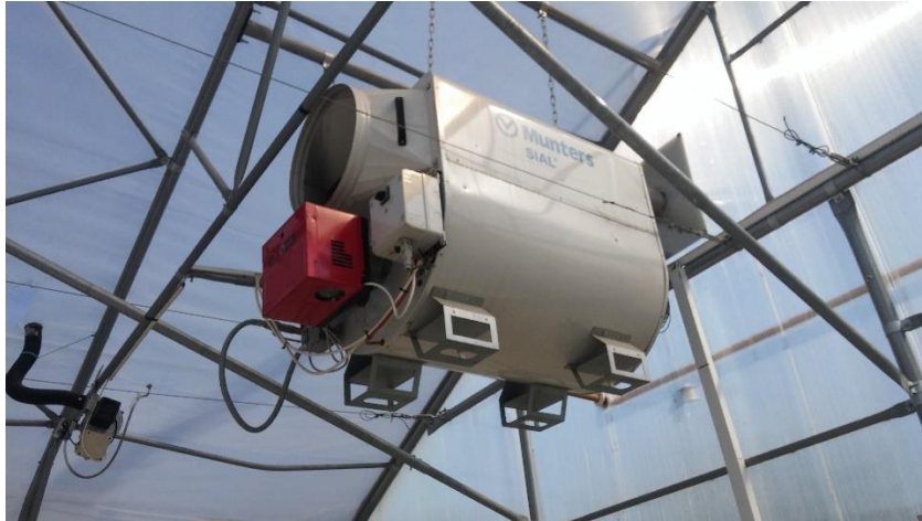
Slika 2.3. Uređaj za proizvodnju toplog zraka
