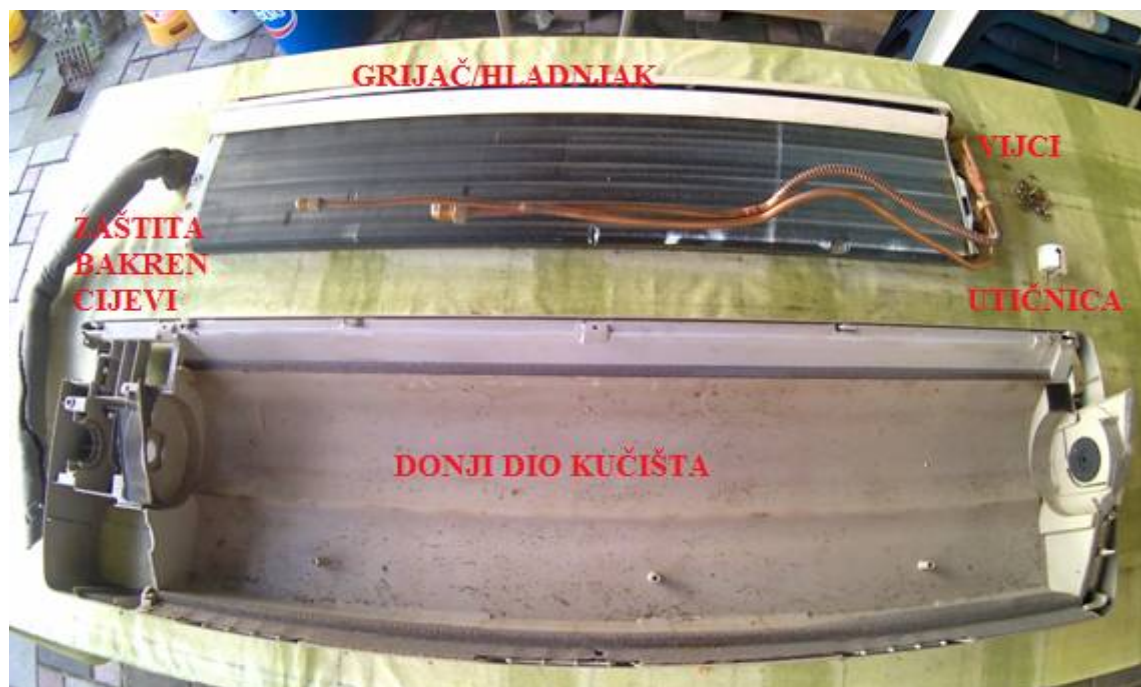
Slika 4.5. Pojedini sklopovi klima uređaja
