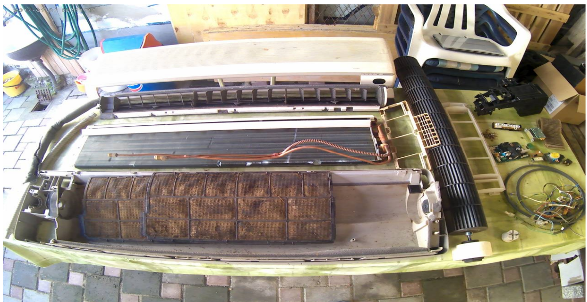
Slika 4.3. Rastavljena unutarnja jedinica klima uređaja
