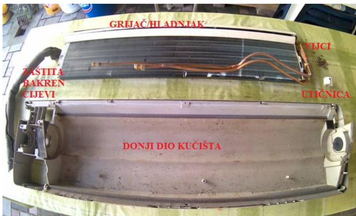
Slika 4.5. Pojedini sklopovi klima uređaja
