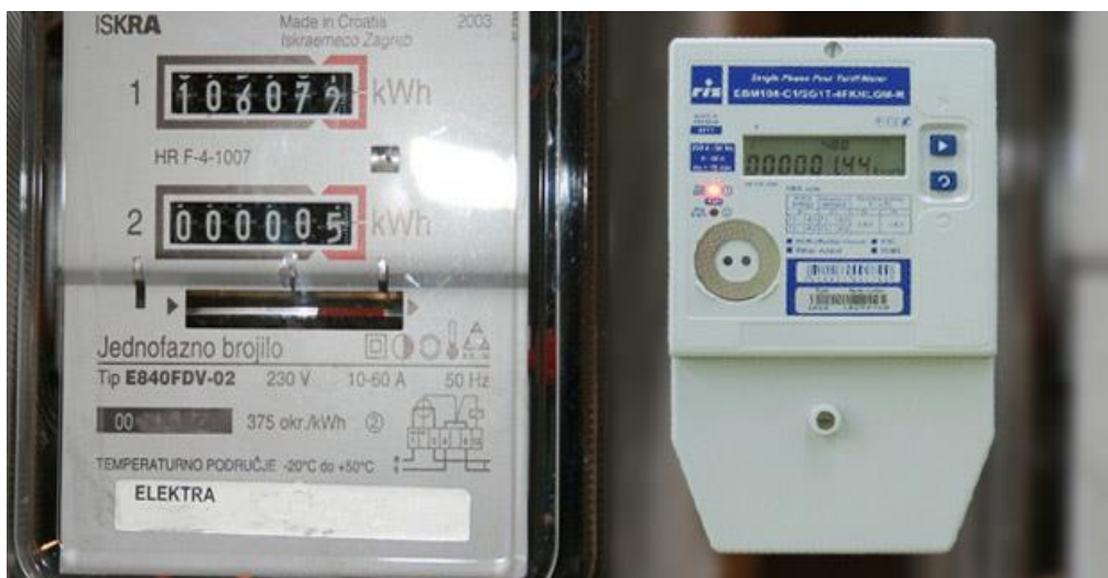
Sl. 4.9. Elektromehaničko jednofazno brojilo i pametno brojilo [20]
