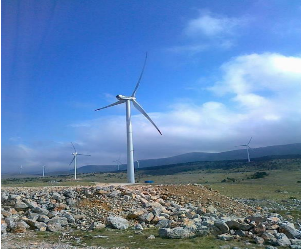
Sl. 4.2. Vjetroelektrana Vrataruša (42 MW) [10]
