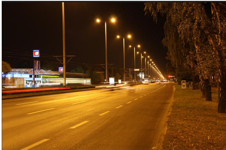
Slika 4.1. Javna rasvjeta ceste. [4]
