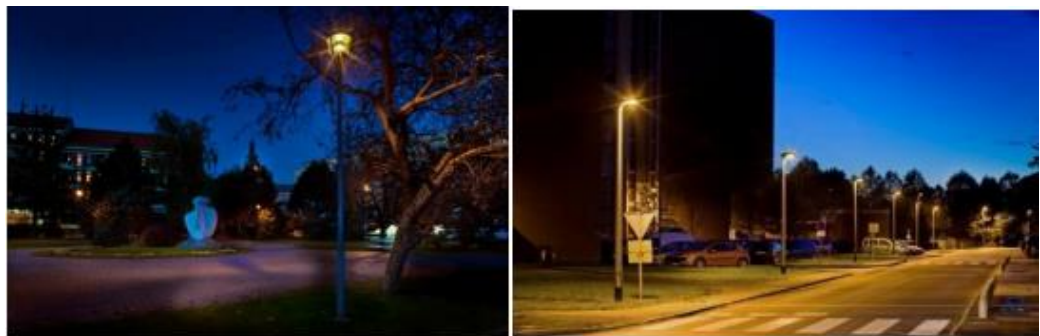
Slika 4.2. Lijevo je prikazana rasvjeta za pješake, a desno javna rasvjeta za cestovni promet [6]
