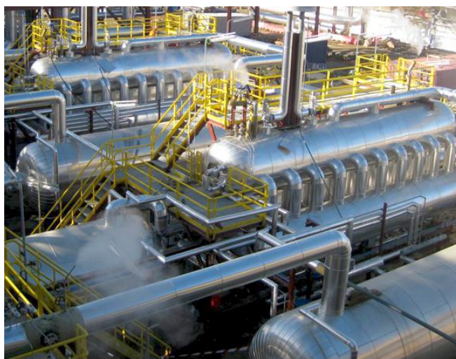
Sl.2.7. Generator pare [7].
