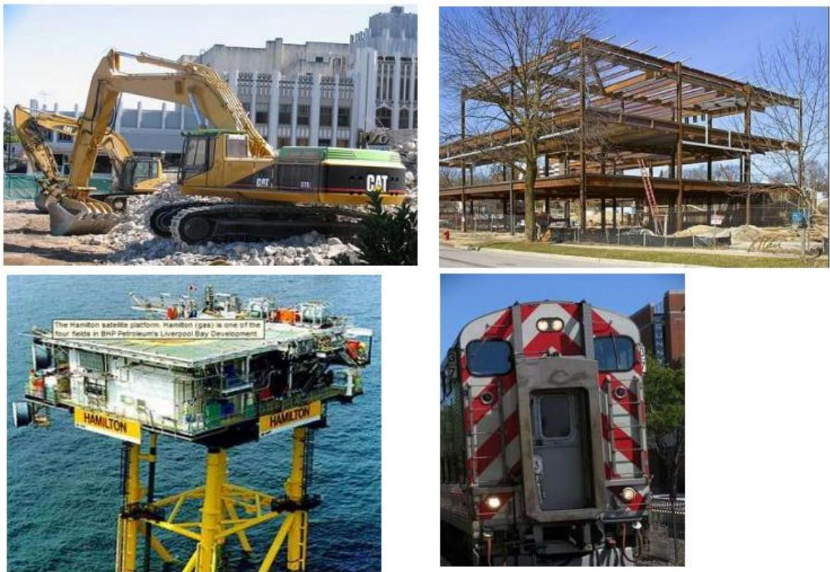
**Slika 1.8** Primjeri primjene nelegiranih konstrukcijskih čelika [2]
