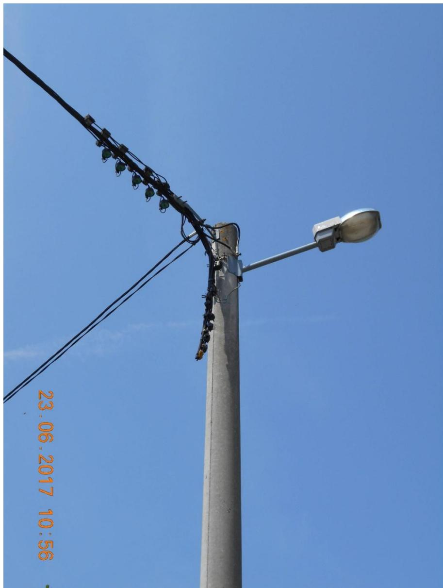
*Slika 3.4. Zatezni betonski stup s kućnim priključkom i javnom rasvjetom*
