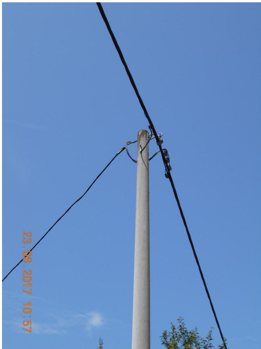
*Slika 3.2. Linijski nosivi betonski stup s kućnim priključkom*
