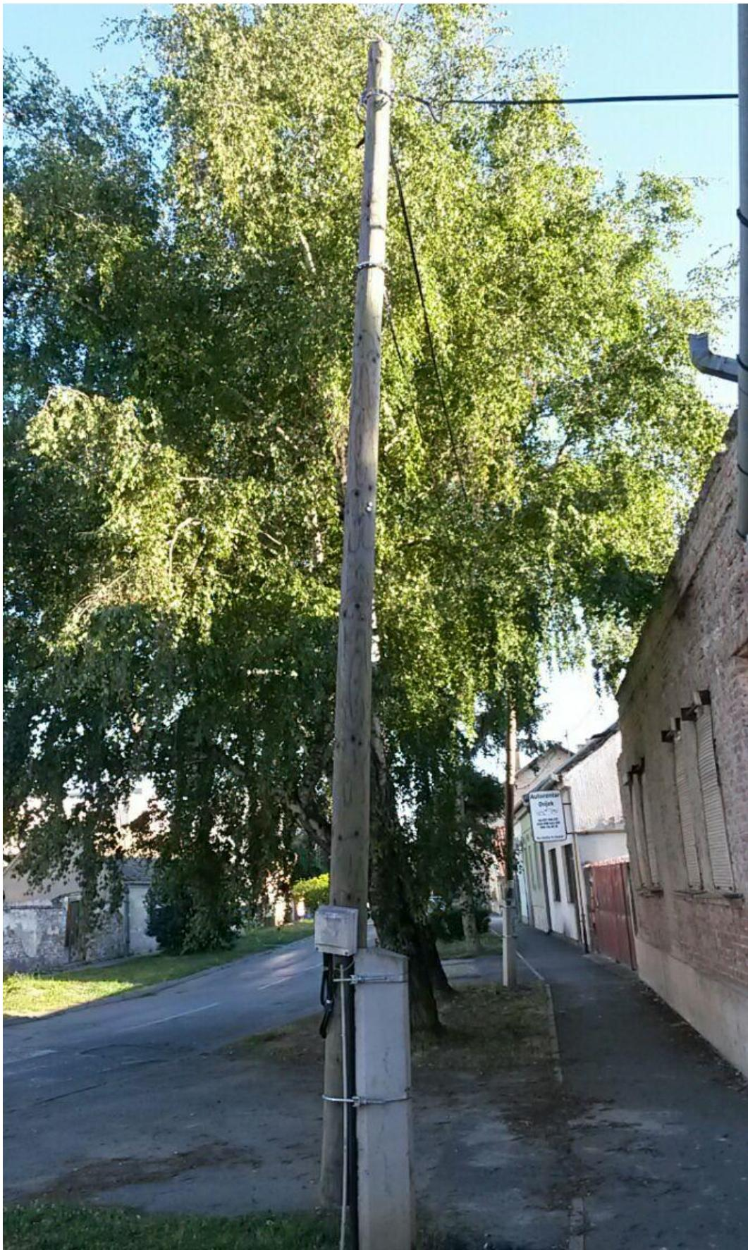
*Slika 2.6. Drveni stup s betonskim temeljem i samonosivim kabelskim snopom*
