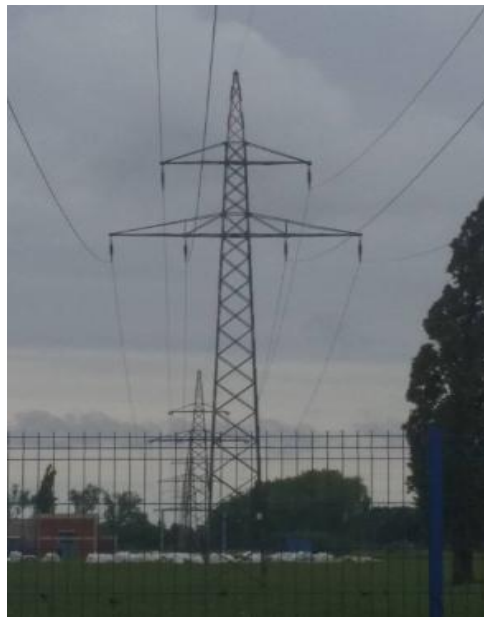
Sl.2.9. Dvostruko čelično-rešetkasti stup, oblik "Dunav"
