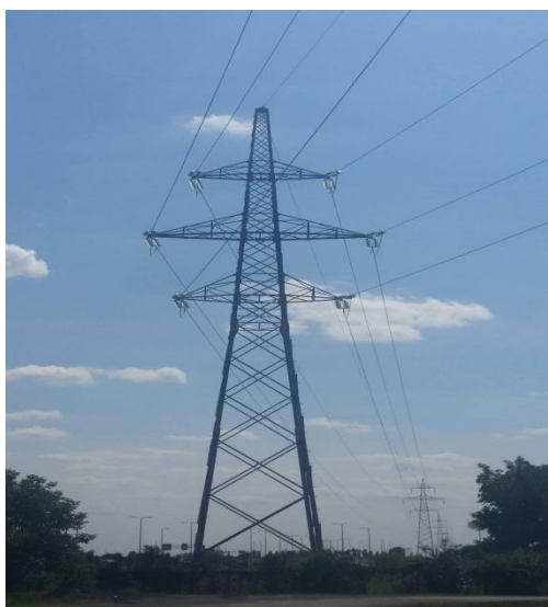
Sl.2.10. Dvostruko čelično-rešetkasti stup, oblik "bačva"
