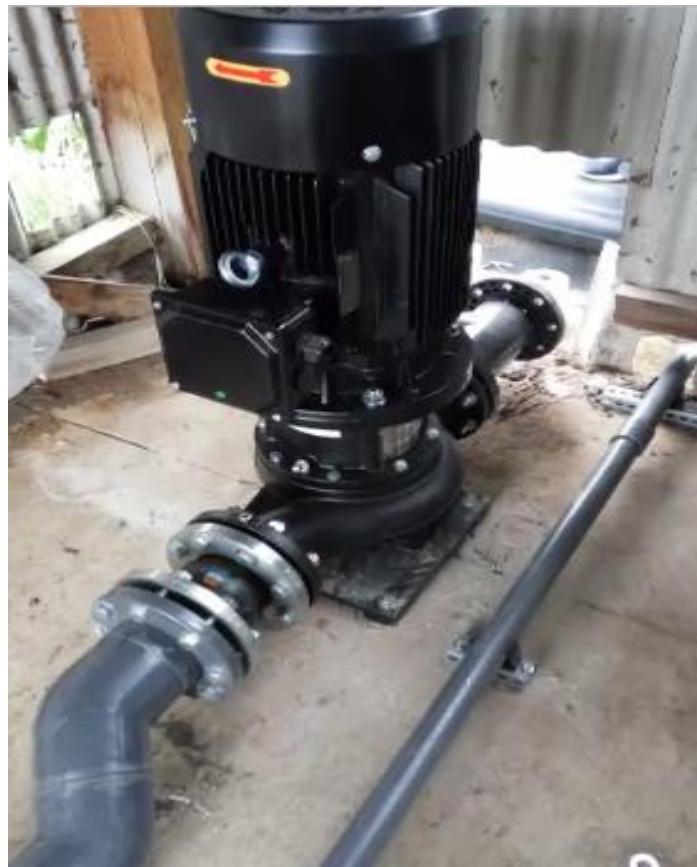
**Sl.13.** Nova fotonaponska električna crpka [3]
