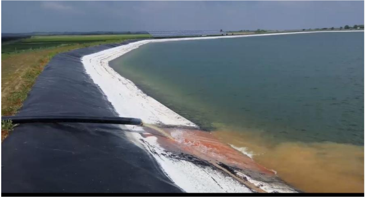
Sl.21. Prikaz akumulacije iz kojeg crpka crpi vodu [3]
