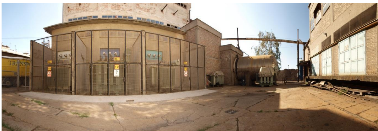
Slika 8.1. Transformatori 35/6,3 kV u Tvornici šećera Osijek
