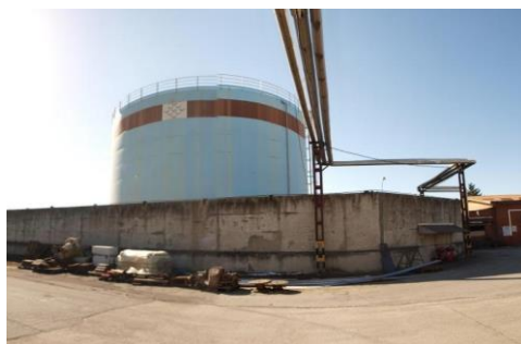
Slika 4.3. Spremnik za mazut u Tvornici šećera Osijek
