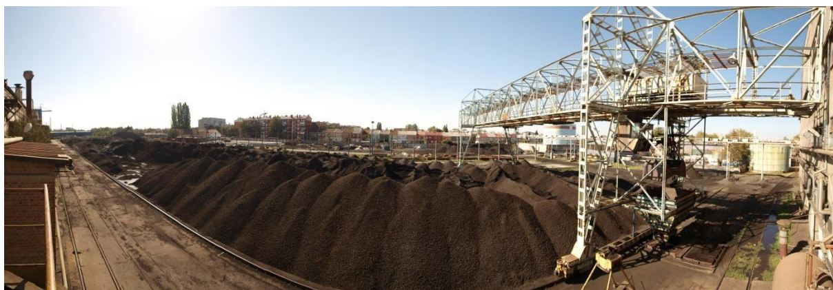
Slika 4.2. Pista za skladištenje uglja i portalna dizalica
