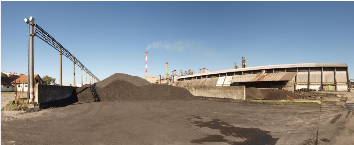
Slika 4.4. Pista za skladištenje koksa
