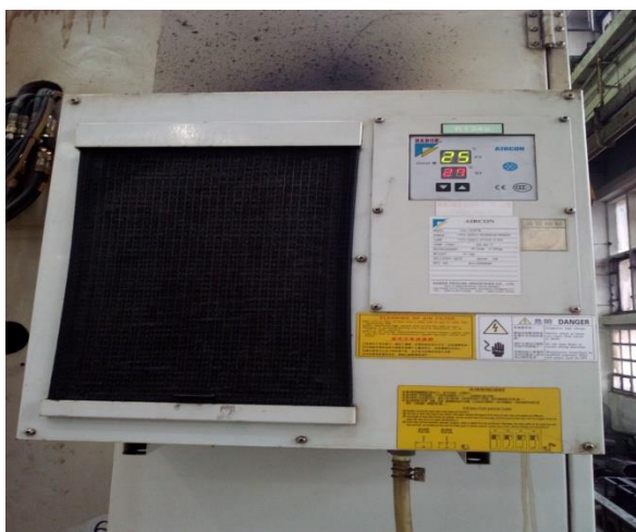
Slika 4.7. Klima koja hladi glavne pogonske motore, (Fotografirano 12.11.2017.)
