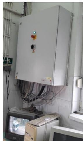
**Slika 4.3** Razvodni ormar za sondu
