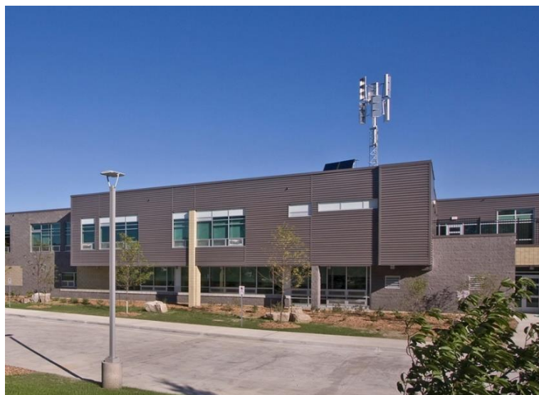
Slika 3.1. Vjetrogenerator na krovu škole Dr. David Suzuki u Kanadi [7]
