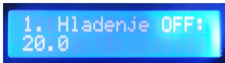
Slika 5.5. Postavljanje temperature na kojoj će se gasiti hlađenja za 1. senzor
