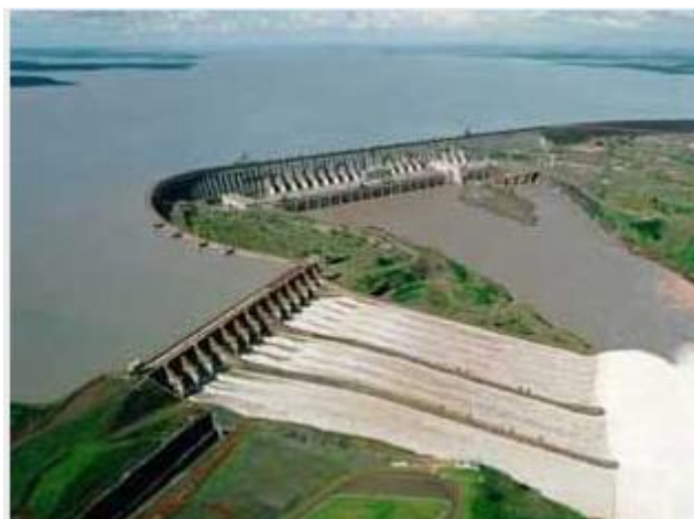
Slika 2.5. Hidroelektrana u Itaipu [21]
