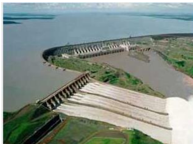
Slika 2.5. Hidroelektrana u Itaipu [21]
