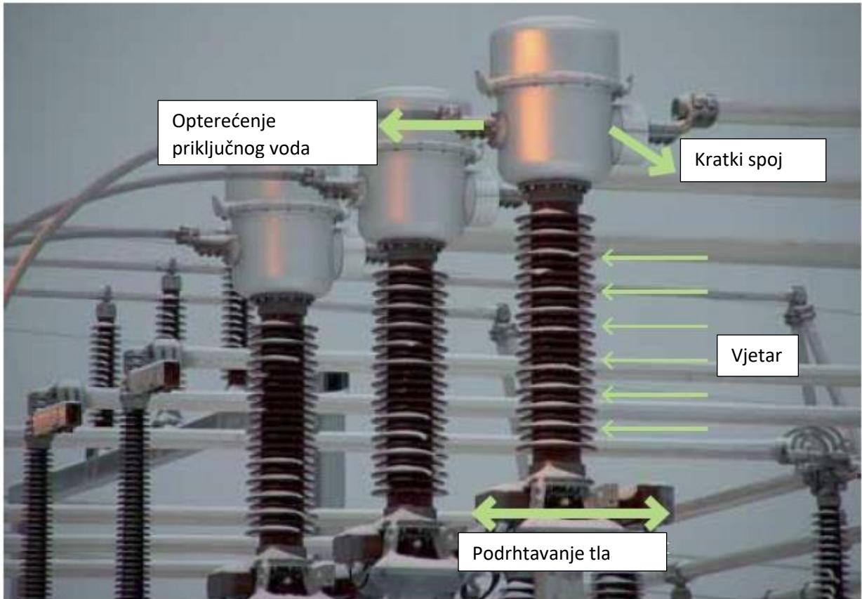
*Slika 2.2.2.1. – Mehanička naprezanja na mjernim transformatorima*
