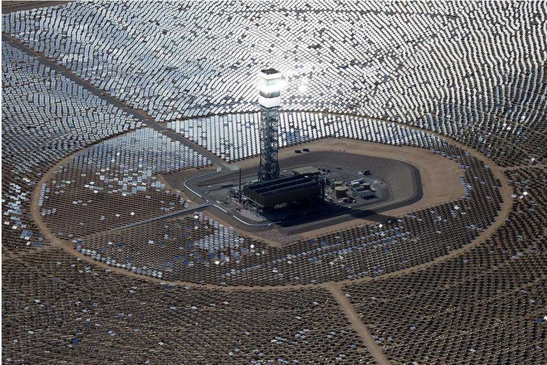
Slika 3.6. Solarni toranj Ivanpah Dry Lake [17]
