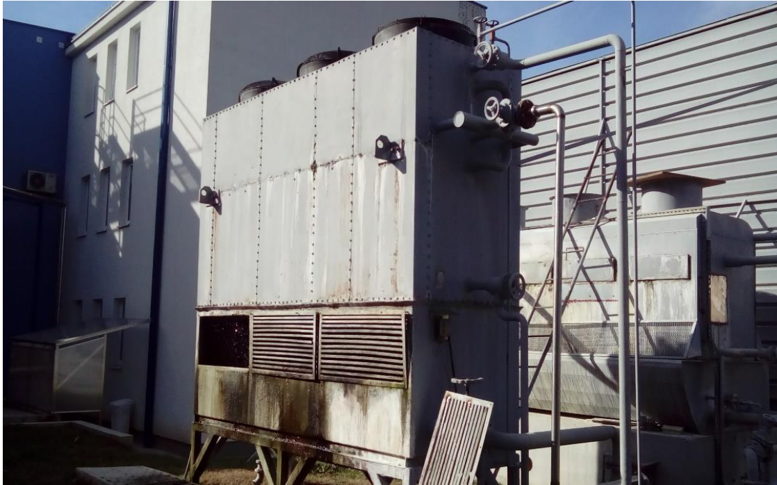
Slika 4.4. Evaporativni kondenzator
