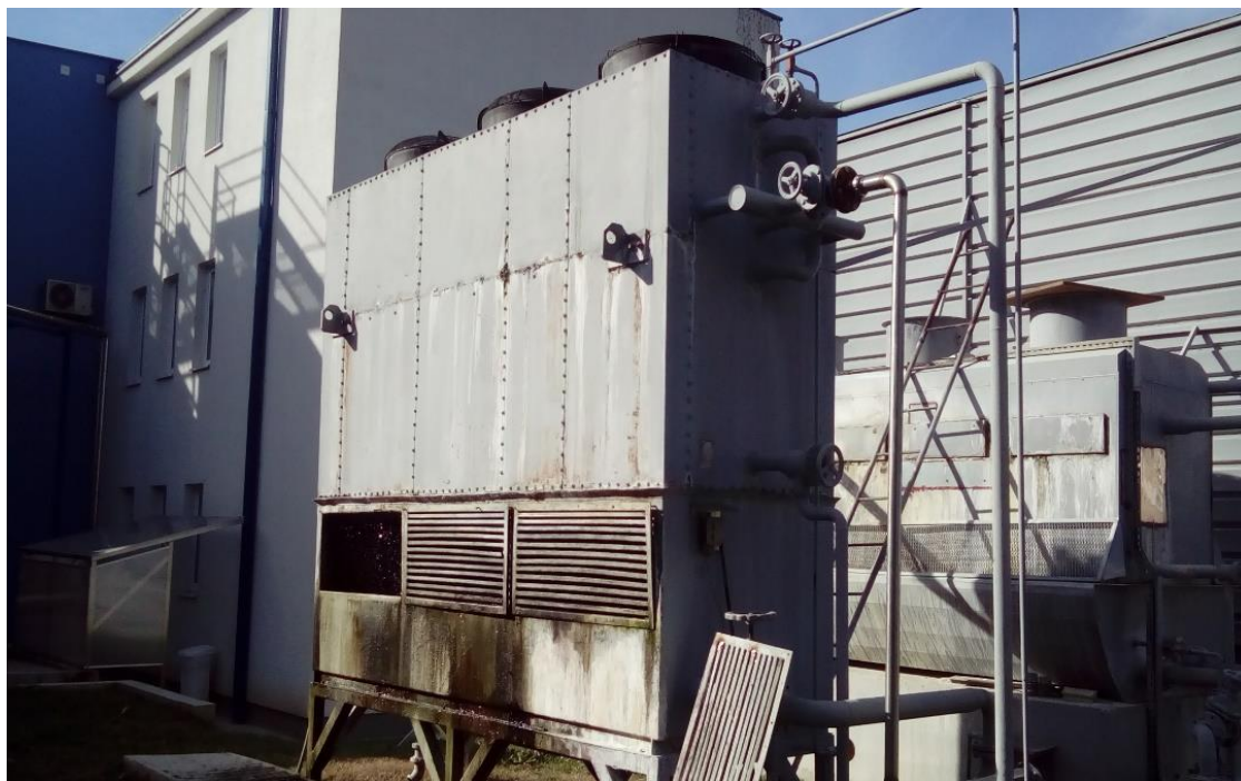
Slika 4.4. Evaporativni kondenzator
