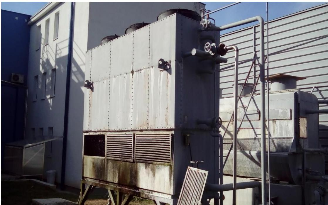
**Slika 4.4.** Evaporativni kondenzator
