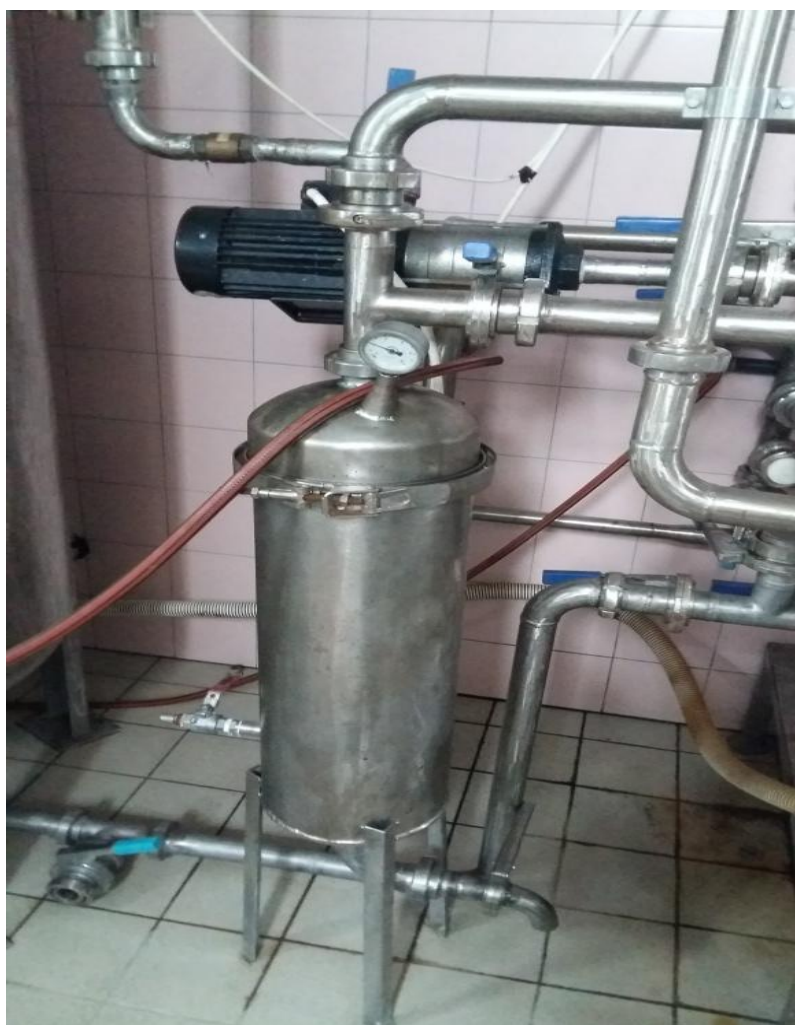
Slika 3.2. Filter za vodu
