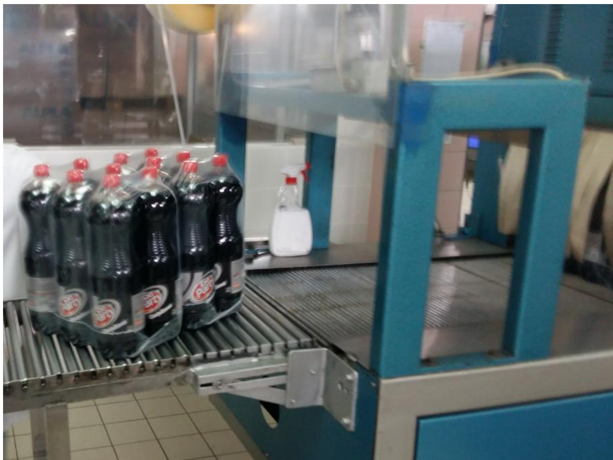
Slika 3.27. Kraj termotunela- dio gdje izlaze gotovi paketi
