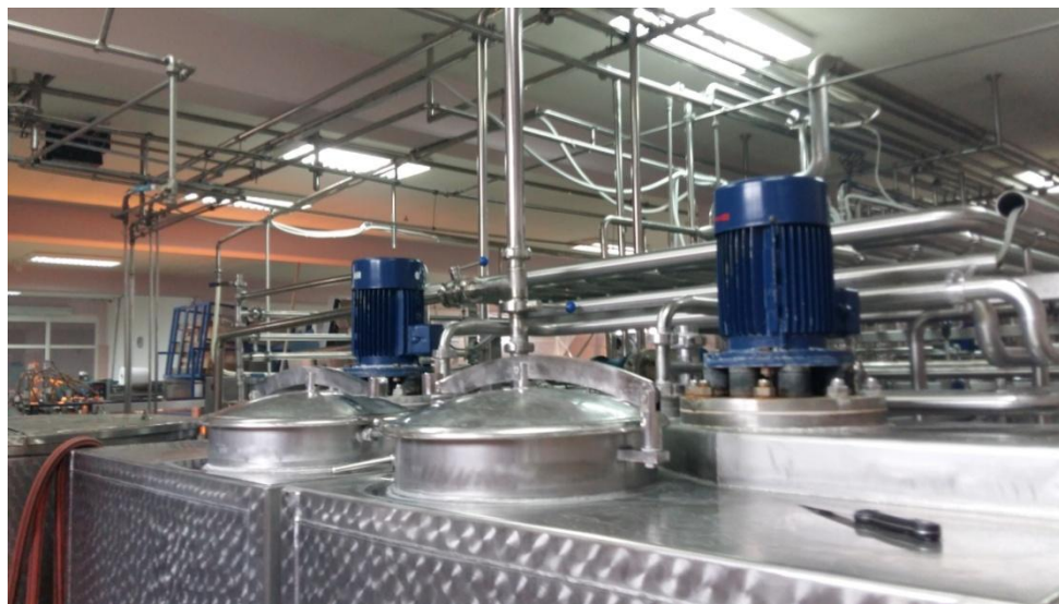
Slika 3.5. Tankeri za miješanje i elektromotori
