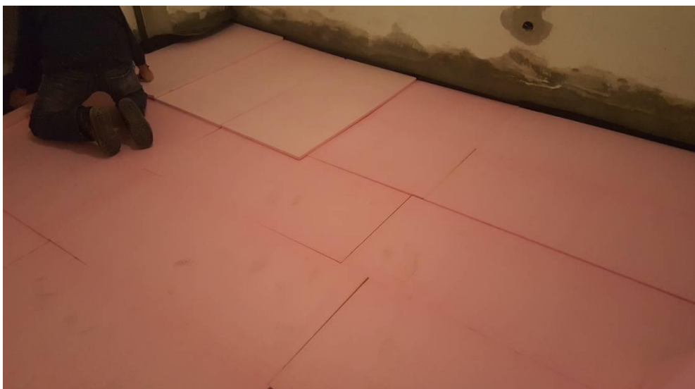
Slika 4.12. Postavljanje ekstrudirane polistirenske pjene
