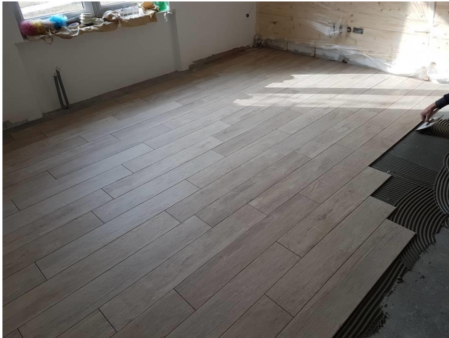
Slika 4.18. Postavljanje keramičkih pločica
