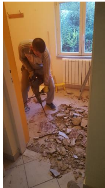
Slika 4.10. Uklanjanje postojećeg poda
