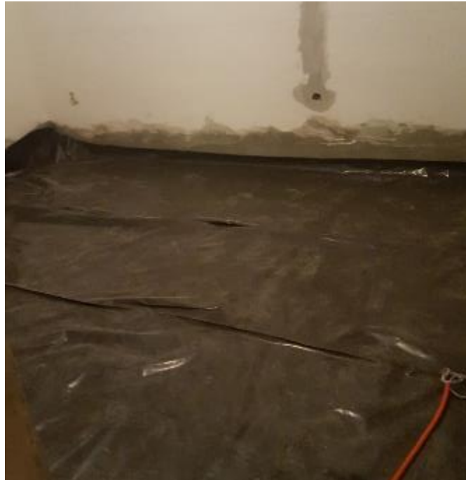
Slika 4.11. Postavljanje PE folije
