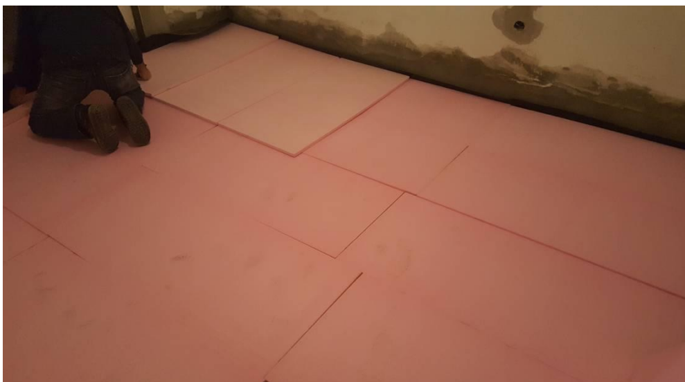
Slika 4.12. Postavljanje ekstrudirane polistirenske pjene
