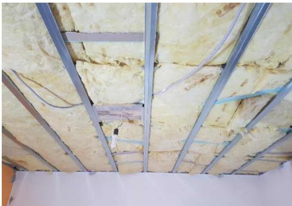
Slika 4.5. Postavljanje mineralne staklene vune prema HRN EN 13162
