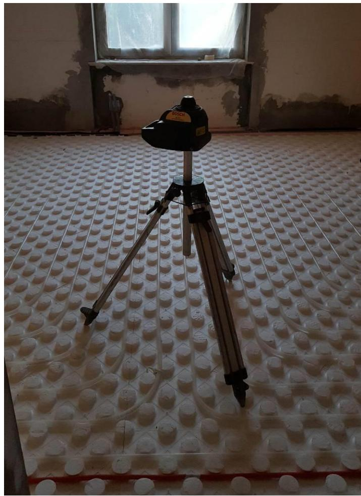
**Slika 4.14.** Laserski uređaj za određivanje „vagresa“ tj. referentne linije za određivanje visine estriha
