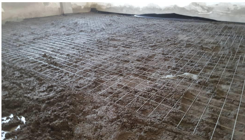
Slika 4.16. Izrada estriha i postavljanje mrežice od pocinčanog željeza
