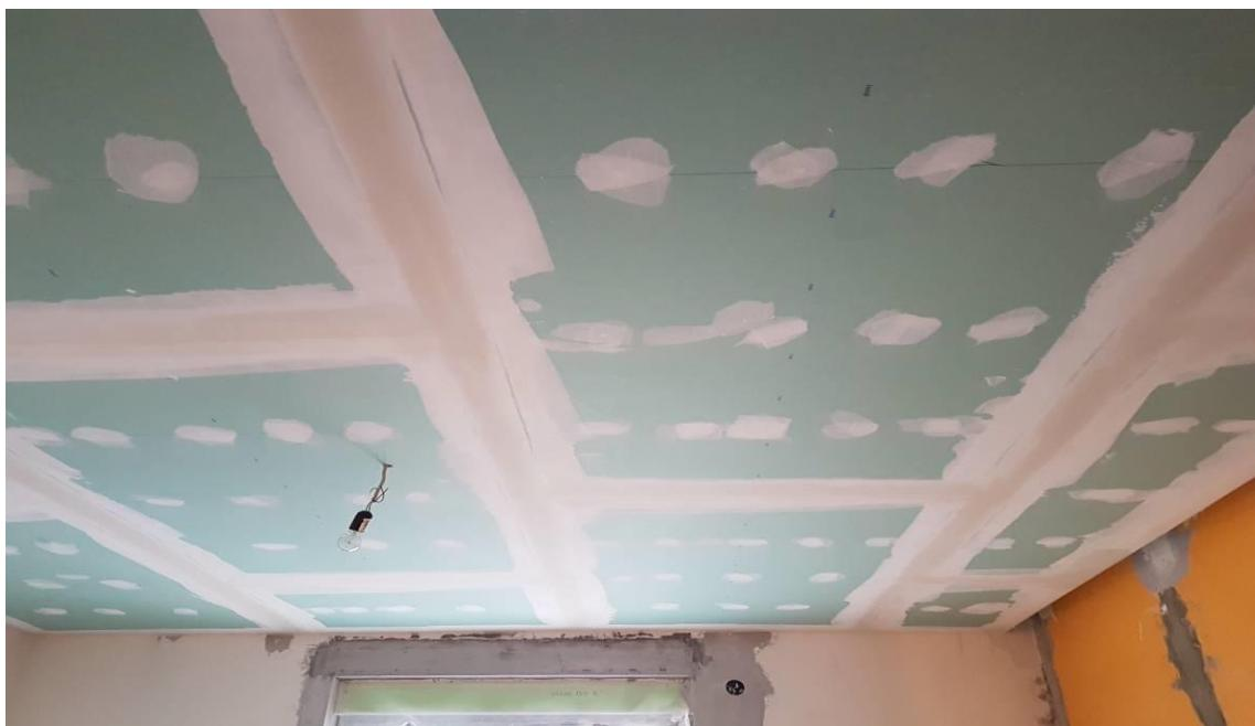
**Slika 4.8.** Postavljanje vodonepropusnih gipskartonskih ploča
