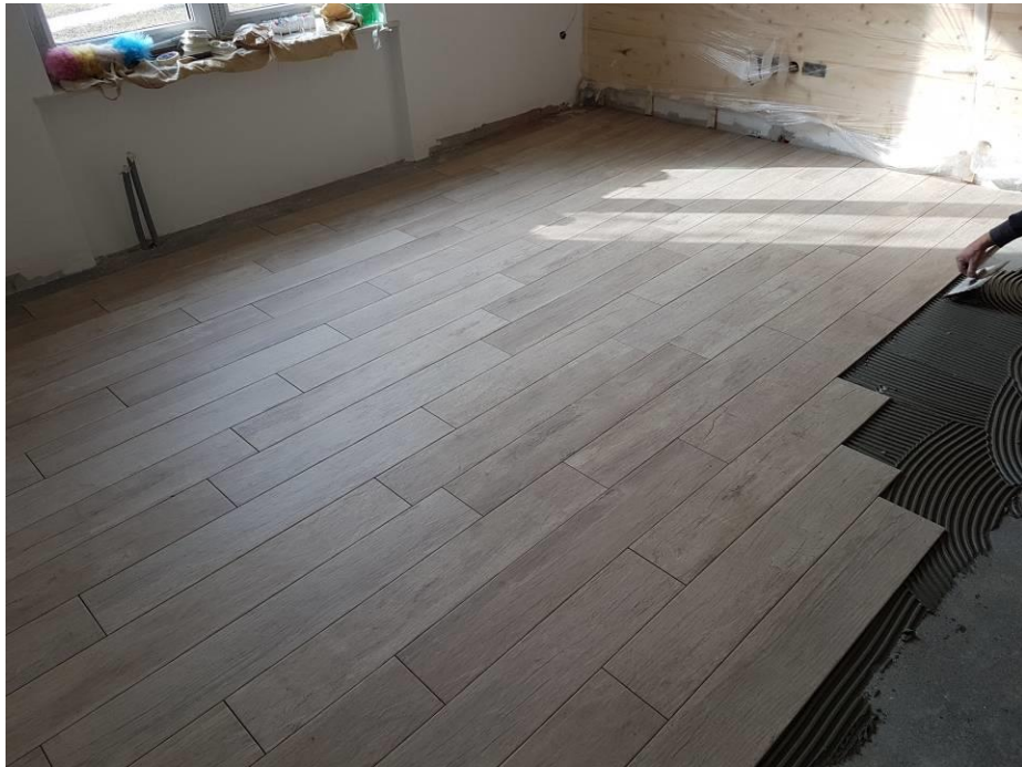
Slika 4.18. Postavljanje keramičkih pločica
