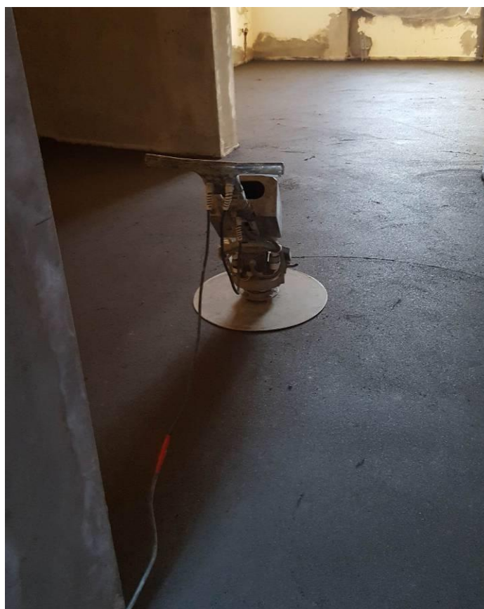
Slika 4.17. Vibrirajući stroj za nabijanje i zaglađivanje estriha
